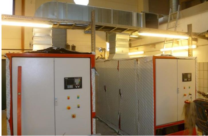
**Neue BHKW-Aggregate während der Installation**
